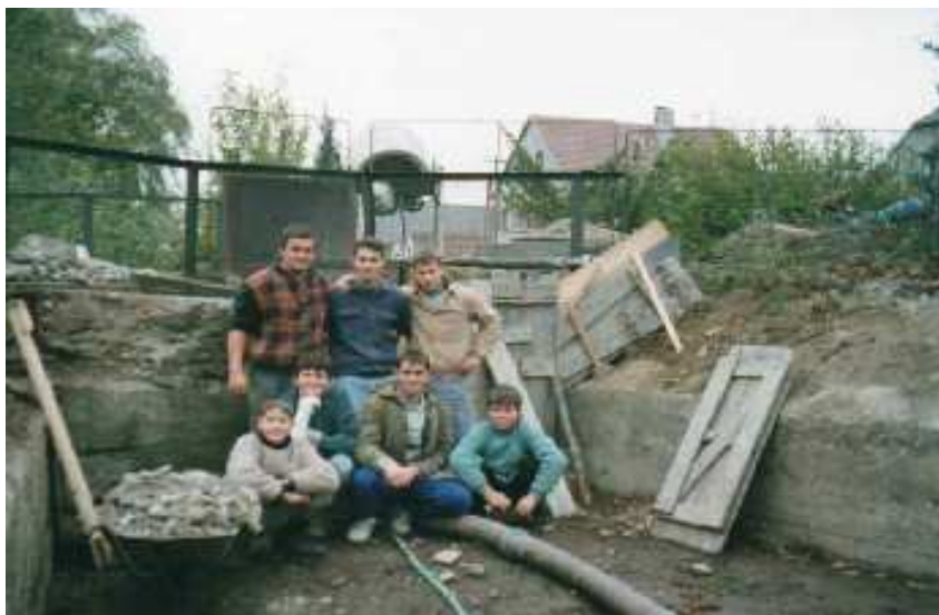
Oprava hráze nádrže – stojící: J. Štika ml., R. Hrachovec, M. Žouželka dole: P. Okrajek, Jan Blaha, O. Blaha, P. Krajc
