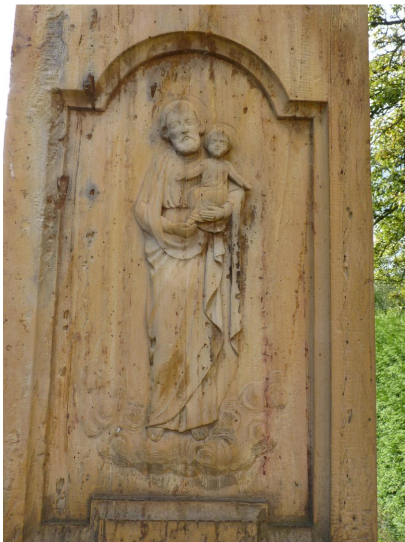
Sokl s reliéfy je poškozen korozí kamen, projevující se zvětváním pískovce a úbytkem původní hmoty kamene.
