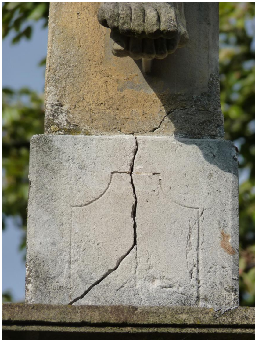
Poškozená pata kříže vlivem korodovaného železného čepu.
