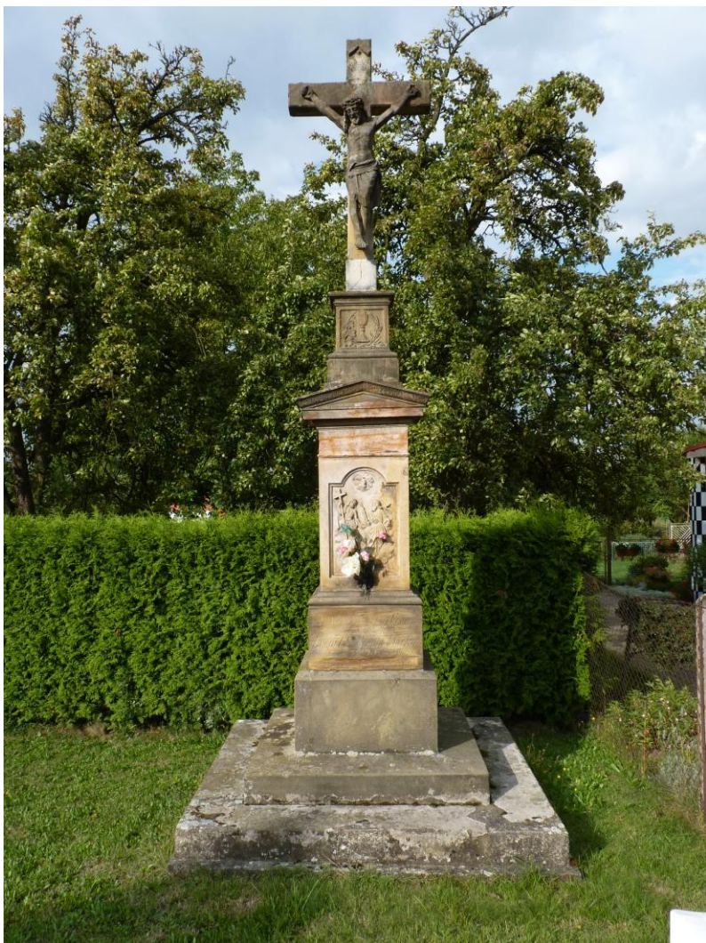
Celkový pohled - Horní část kříže se nachází v havarijním stavu, hrozí zřícení horní části kříže s korpusem vlivem korodujícího železného čepu, který způsobil roztrhnutí paty kříže.
