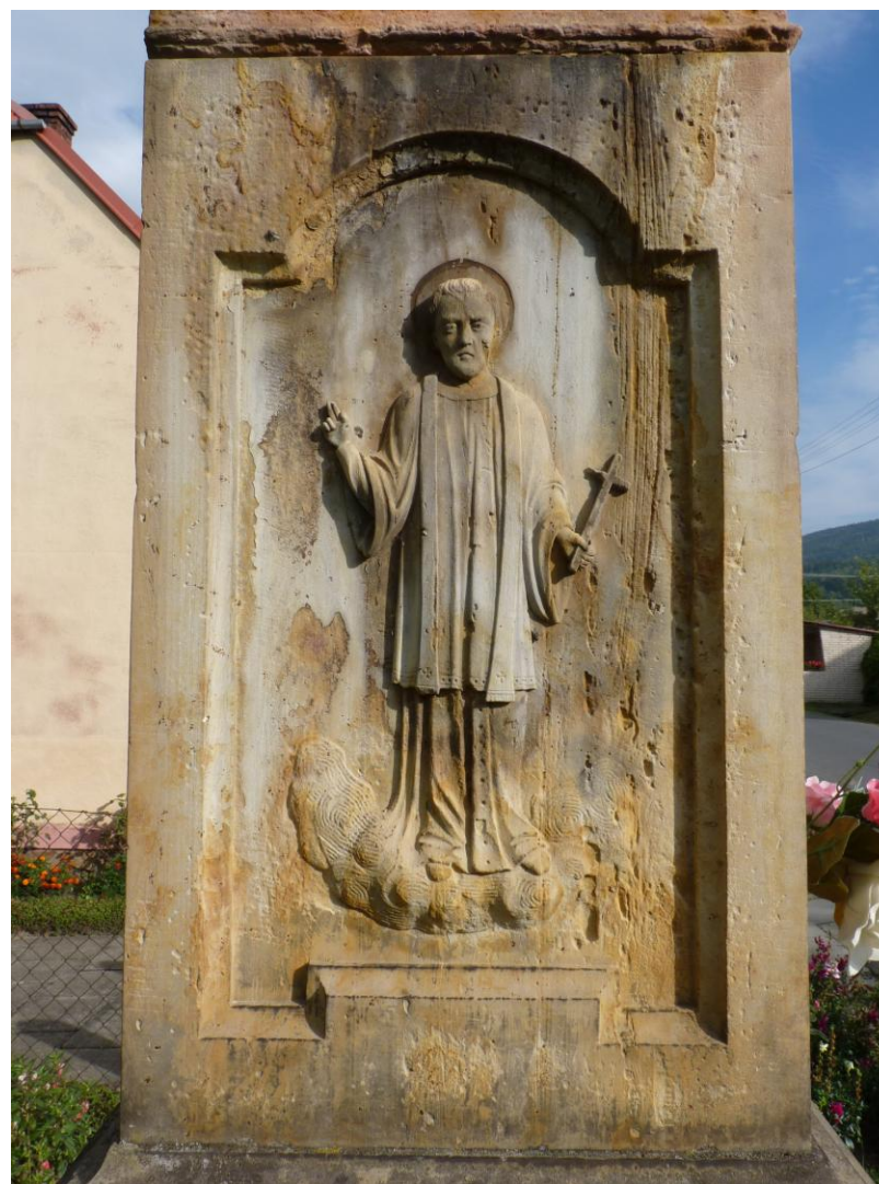
Sokl s reliéfy je poškozen korozí kamen, projevující se zvětváním pískovce a úbytkem původní hmoty kamene.
