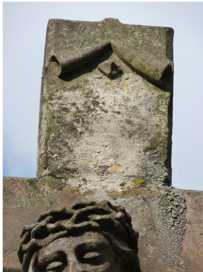
Detail poškození nápisového štítku I.N.R.I.
