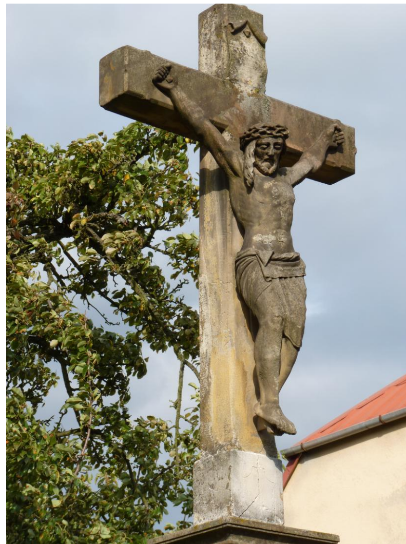
Celkový pohled - Horní část kříže se nachází v havarijním stavu, hrozí zřícení horní části kříže s korpusem vlivem korodujícího železného čepu, který způsobil roztrhnutí paty kříže.
