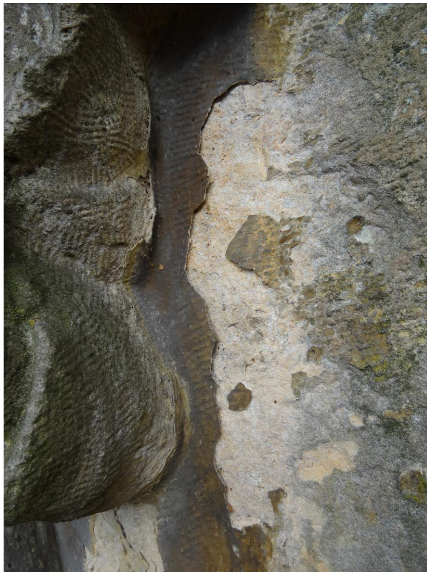
Stav před obnovou - detail poškození nevhodným nátěrem, zasolením kamene a krustami.
