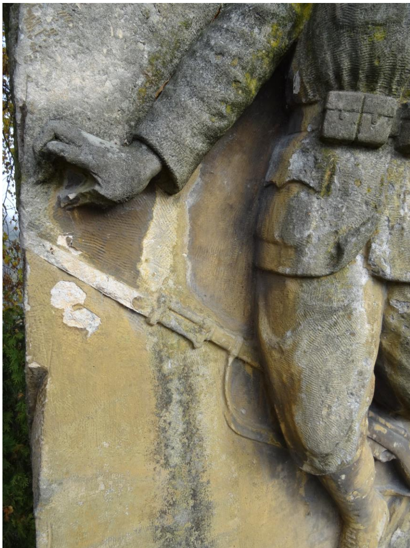
Stav před obnovou - detail poškození nevhodným nátěrem, zasolením kamene a krustami.
